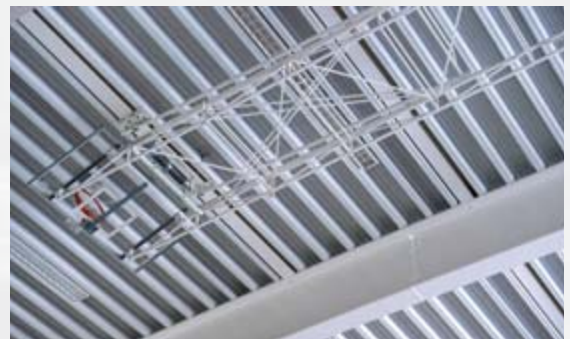
Dieser auf dem Bau zusammenschweisste Doppel-T-Träger der Ausführungsklasse EXC 3.
