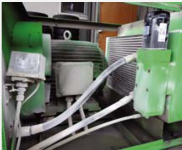
Kompressor vorher und nachher. Compresseur avant et après.
